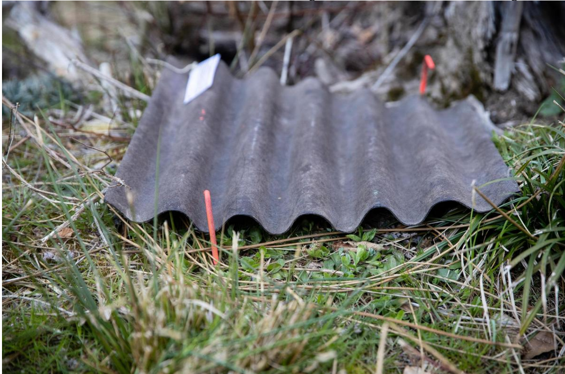
Bitumenplatte mit typischer Wellung.
